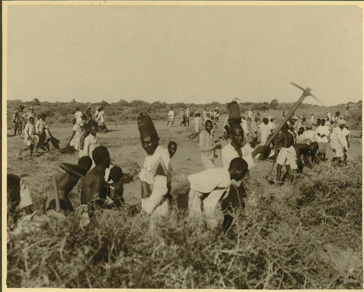
ASCARI AI LAVORI STRADALI
