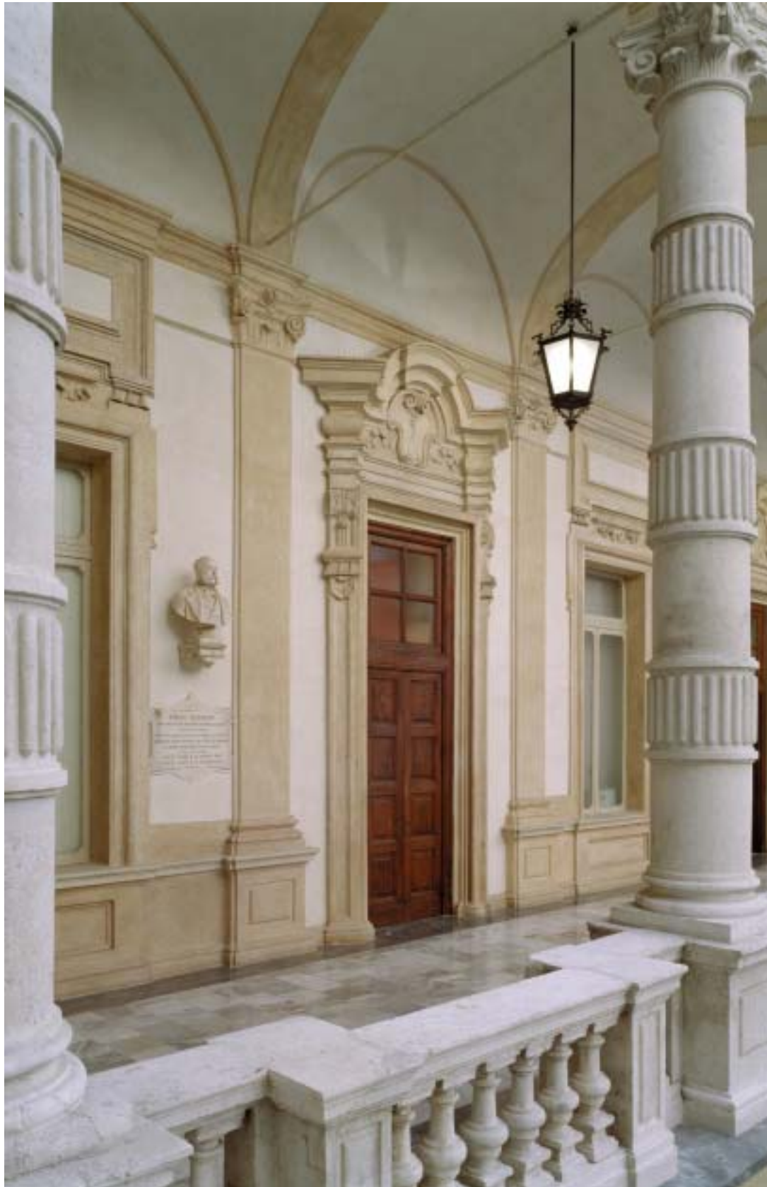
Fig. 10. Palazzo dell'Università, loggiato con i montanti laterali delle cornici delle porte ruotati a 45^\circ rispetto al piano del muro retrostante, realizzati su disegno di Filippo Juvarra (Archivio Immagini Università di Torino, Foto Flavio Tiengo).
