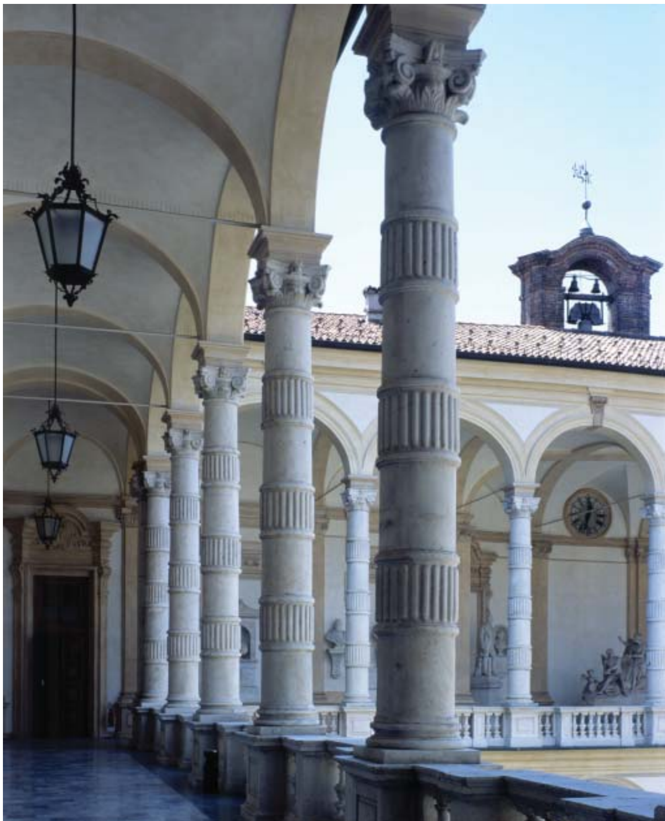
Fig. 5. Palazzo dell'Università, loggiato con il piccolo campanile. Sullo sfondo compare, sotto l'orologio interno, il gruppo scultoreo della Fama che incatena il tempo, opera dei fratelli Collino (Foto Vincenzo Pasquali Torino).
