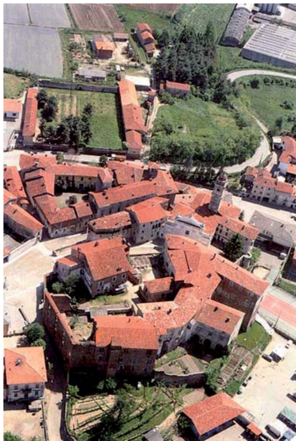
Fig. 3 - Buronzo. Il nucleo interno del castello in una veduta aerea da Nord-Est (da SOMMO 1991, p. 108, Fig. 129).
