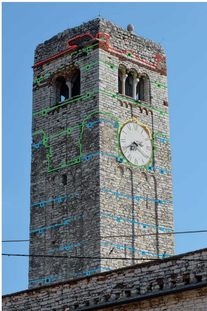
Fig. 18 - San Giorgio di Valpolicella, campanile della pieve, facciate nord e ovest.
