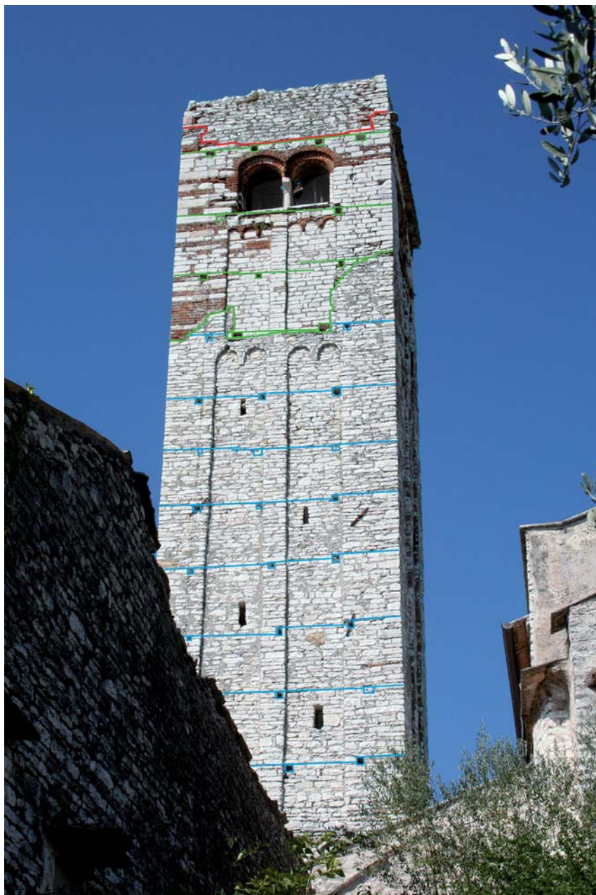
Fig. 17 - San Giorgio di Valpolicella, campanile della pieve, facciata est.
