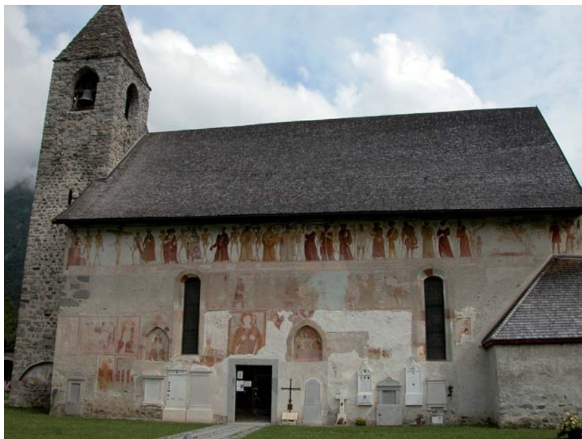
Fig. 26 - Pinzolo, San Vigilio, vista del fianco della chiesa.
