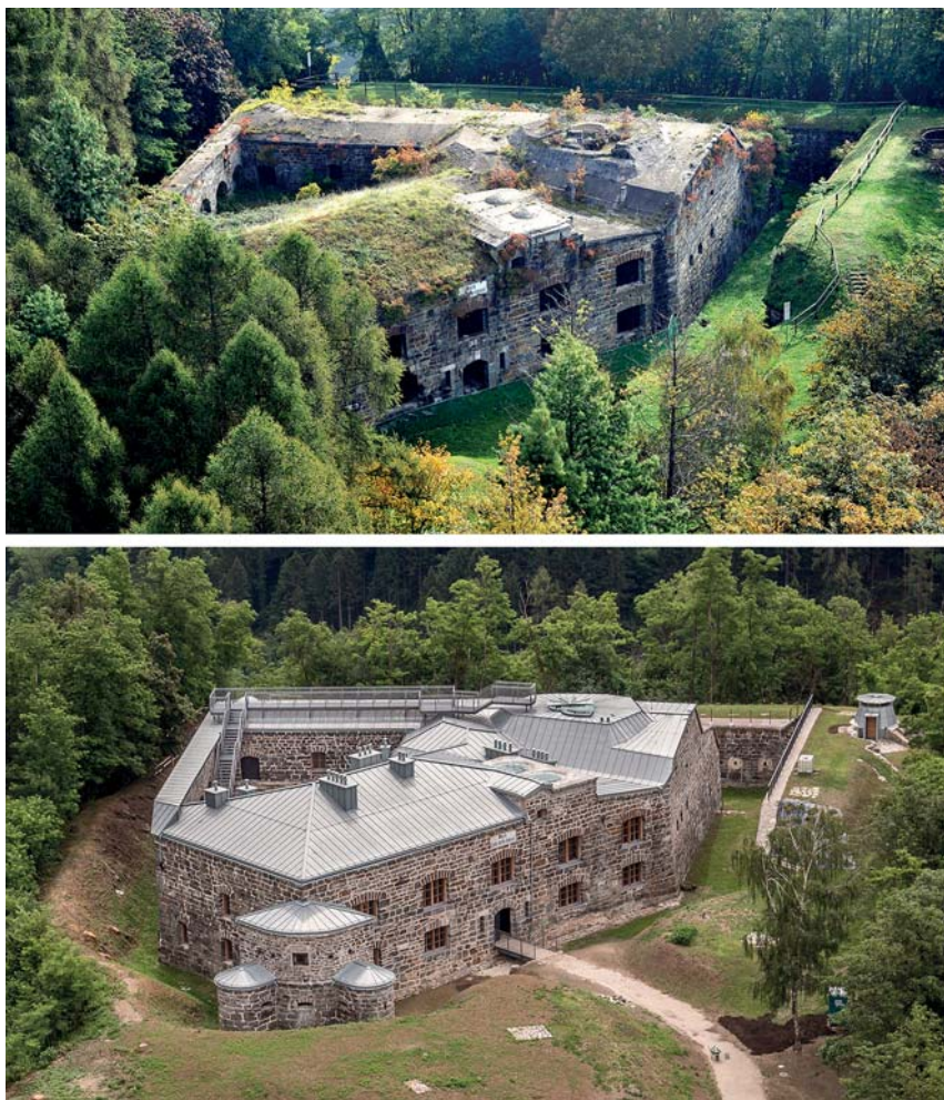
Fig. 7 - Forte San Biagio. Prima e dopo il restauro (Rensi 2010-2014), Soprintendenza Beni culturali, Trento.
