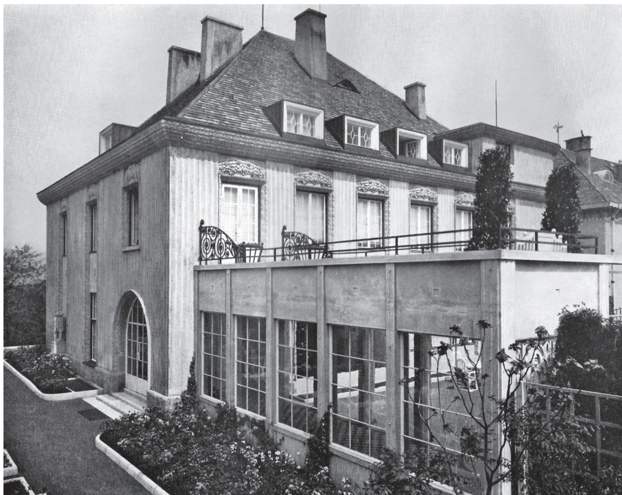
3. Villa Ast sulla Hohe Warte a Vienna (da «Moderne Bauformen», 1913).
