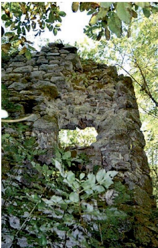
rriva a superare i quattro metri fuori terra, fa supporre che si trattasse di un roccolo a torre, ormai privo di copertura. La pianta ha forma quadrangolare irregolare con lati di circa 4-5 metri e angolate smussate. All'interno, sul fronte nord, è visibile la sagoma di un camino, il cui vano intonacato è parzialmente ridotto da contromurature in mattoni addossate in fase posteriore.
