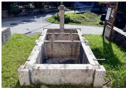
La fontana collocata in prossimità della chiesetta dell'Assunta, in località Valt a Montagnaga di Pinè, è inserita in uno spazio di forma rettangolare delimitato da un muretto perimetrale; è composta da tre vasche in pietra carbonatica, formate da lastre collegate a pilastri quadrangolari con staffe metalliche e da una colonna erogatrice in pietra con parte sommitale a dado.
