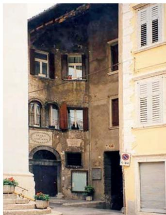
Gravemente danneggiata da un bombardamento durante la Prima guerra mondiale, la casa subì nella fase post bellica una ricostruzione 'd'emergenza' connotata da povertà formale e dall'introduzione di elementi in calcestruzzo e acciaio. All'interno, l'assetto distributivo e le fasi costruttive più antiche sono leggibili soprattutto nel livello terreno e al primo piano.
