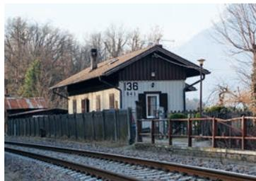
con copertura a capanna, declina i comuni stilemi mitteleuropei tipici dell'architettura ferroviaria *fin de siècle*, con limitati adattamenti al gusto locale. Le fronti sono rivestite in listelli lignei, a foderare in modo differente la parte alta dei prospetti rispetto a quella inferiore; in legno sono anche le cornici dei serramenti e le mantovane di gronda.
