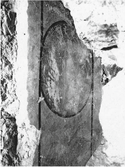
■ 11. Decorazione a finte pietre di un vano di porta, prima metà del XVI secolo, affresco. Trento, Palazzo Sardaña, primo piano (oggi murata)
