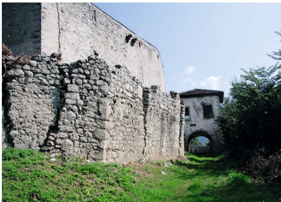
■ 2. Campodenno (Trento), Castel Belasi: particolare della seconda cinta muraria e del rivellino prima del restauro
