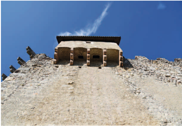
■ 10. Campodenno (Trento), Castel Belasi: particolare delle mura con la bertesca ad est
