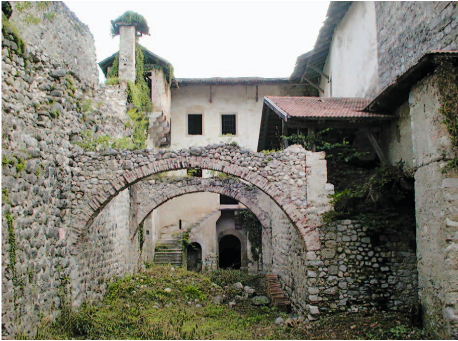
■ 4. Campodenno (Trento), Castel Belasi: particolare dell'area ad ovest prima del restauro
