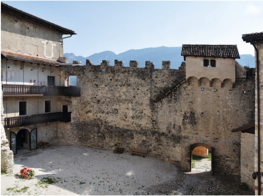
■ 15. Campodenno (Trento), Castel Belasi: particolare del cortile principale dopo il restauro
