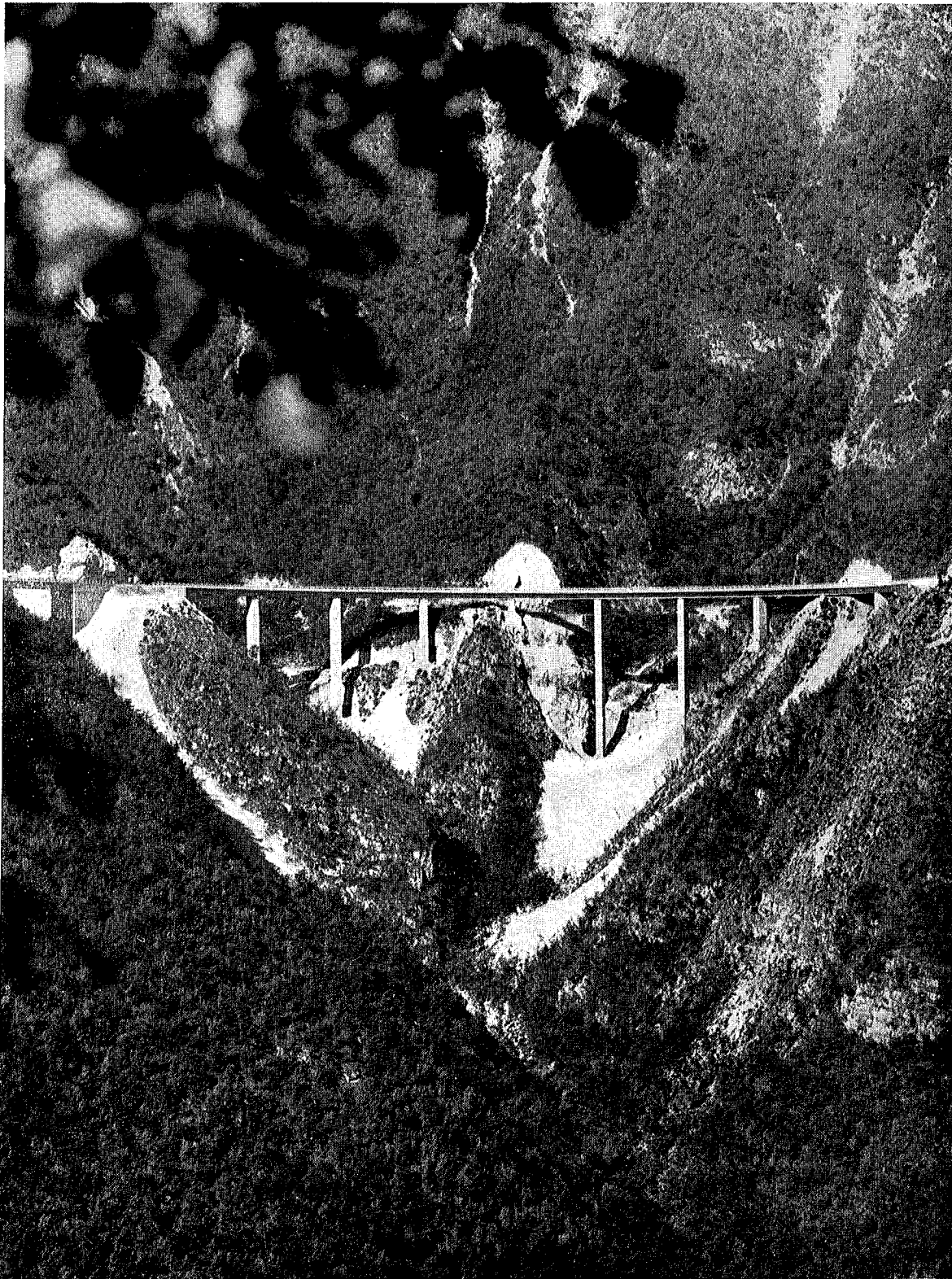
Veduta panoramica dell'imponente manufatto di cemento sulla Val del Restel.
