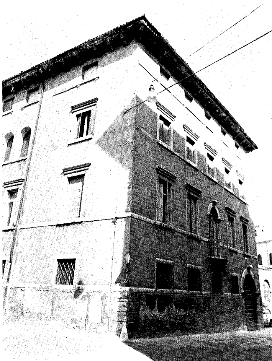
Foto 2: Rovereto, via Calcinari. Facciata volta a mezzogiorno del palazzo edificato nel 1756 dall'industriale Andrea Antonini. Poiché dalle finestre si poteva vedere nell'interno del monastero, Maria Teresa ordinò che le finestre venissero murate. (Foto: Dr. Clemente Lunelli - Trento)
