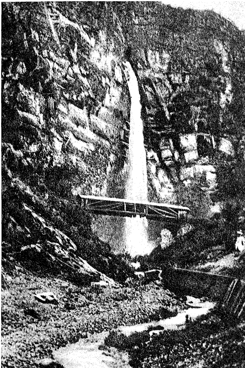
Fig. 2 - Il vecchio ponte coperto, tutto di legno (il precedente costruito nel 1860 era in muratura), lanciato oltre il rio Tigia alle spalle del paese di Salorno.
