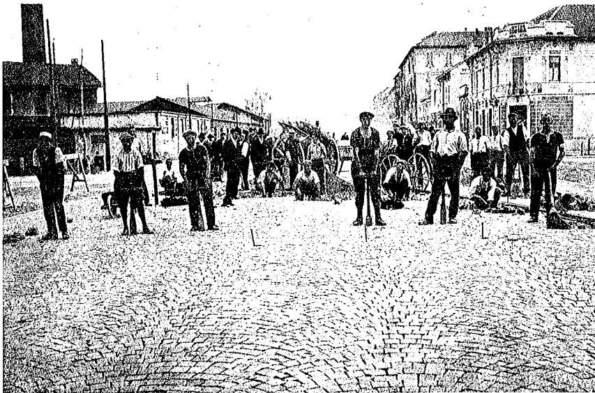
Pavimentazione Corso Ponte Mosca, Torino, 1926; Archivio privato società S.A.L.P. s.a.s. Trento.
