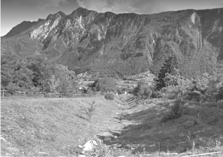
Fig. 2. La Roggia di Novaledo verso sud, vista dalla val Scura
